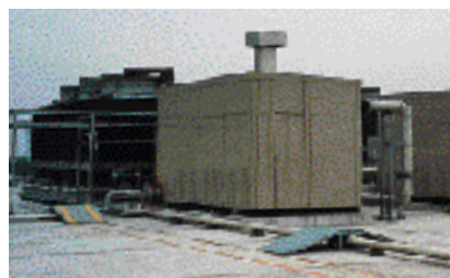
吸収式冷凍機
