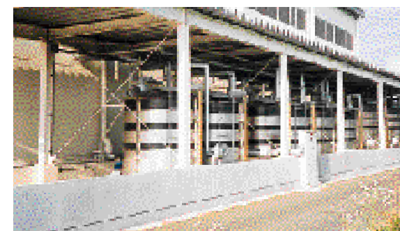
廃液タンク防液堤
