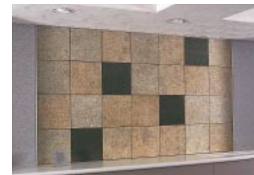
播磨テクノセンター応接室壁面 古紙リサイクルボード貼付事例
