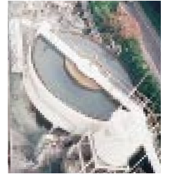
排水処理施設
