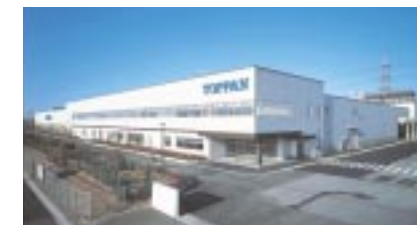
建装材幸手工場
