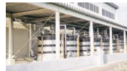
廃液タンク防液堤
