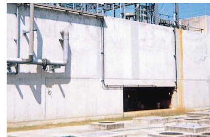
排水処理施設 / 地下からの漏洩点検坑
