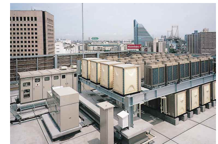
水蓄熱式ヒートポンプ（トッパン芝浦ビル）
