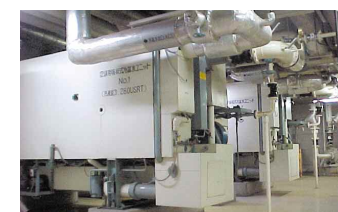
吸気式冷凍機
