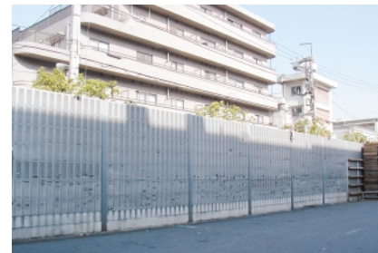
騒音防止のために取り付けられた防音壁(凸版製本(株))
