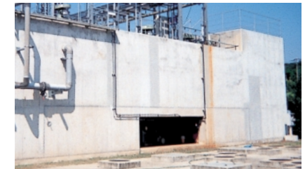
排水処理施設/地下からの漏洩点検
