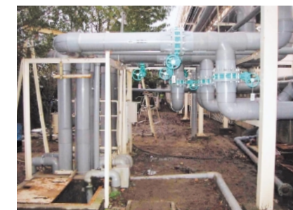
最終排水管への緊急遮断弁の設置
