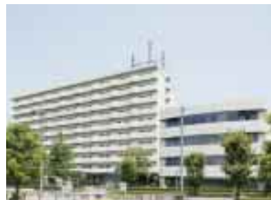
研修棟と宿泊棟を備えた研修センター
