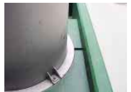
薬液タンク底面漏洩監視用溝
