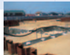
土壌修復工事現場（ブロックごとに土壌を掘削入替）
