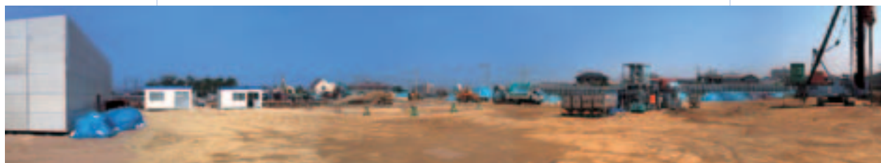
土壌修復・敷地内地下水浄化工事の現場全景（左：地下水浄化装置 右：VOC浄化工事）
