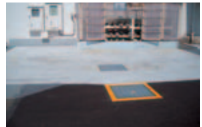
ローリー搬入出口における薬液漏洩を想定し、周囲への拡散と流出を防止するための地下ピットを新設(株)トッパン・エレクトロニクス富士
