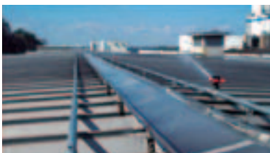
工場の折半屋根へスプリンクラーを設置・散水することで、夏季太陽光輻射熱を軽減し空調負荷を削減(熊本工場)
