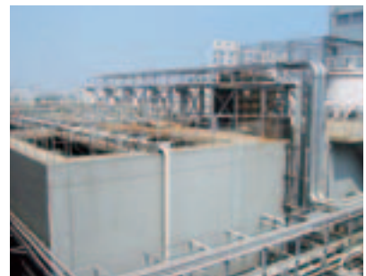
重金属を含む排水を処理するとともに純水としての再生処理を行う排水リサイクルシステム(台湾凸版国際彩光股份有限公司)
