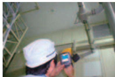
サーモグラフィーによる放熱箇所の点検
