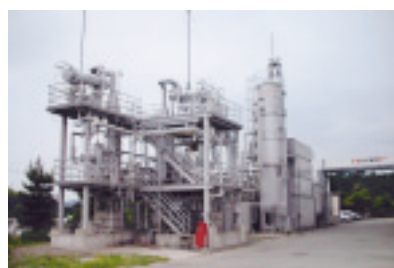
溶剤回収装置(福岡工場)
