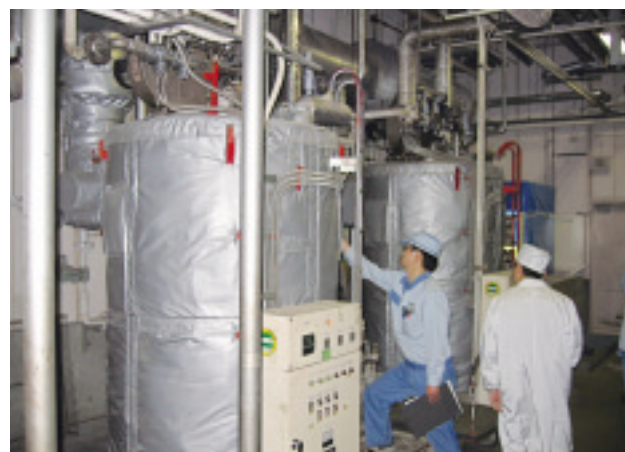
断熱ジャケットによるボイラーの放熱ロス対策
