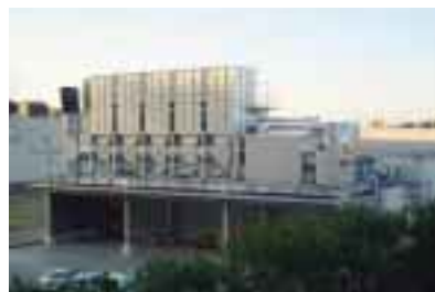
排ガス処理装置 (福岡工場)
