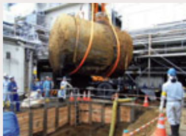
地下タンク撤去
