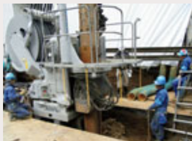
遮水壁延長工事
