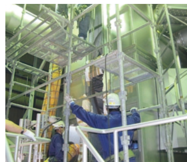
排ガス処理装置入れ替え工事
