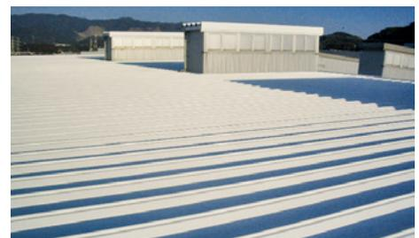
遮熱塗料を塗装した屋根(福岡工場)
