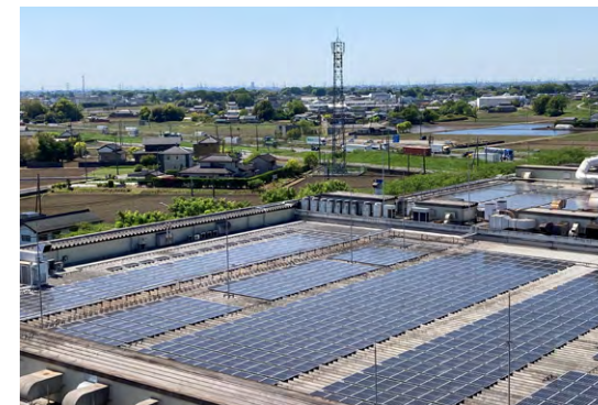
(株)トッパン建築プロダクツの幸手工場B棟屋上
