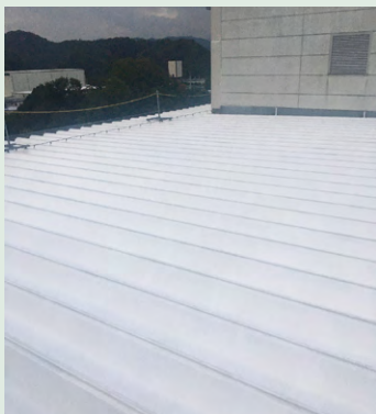
遮熱塗料塗工後の折版屋根
