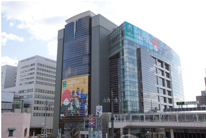
施工完了後の豊田参合館全体図
